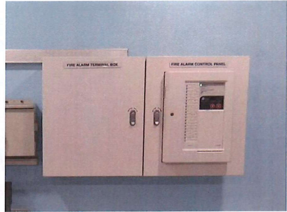
ภาพที่ 56 แผงควบคุมระบบแจ้งเหตุเพลิงไหม้
