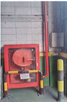
ภาพที่ 59 ท่อเย็นและตู้สายฉีดน้ำดับเพลิง
