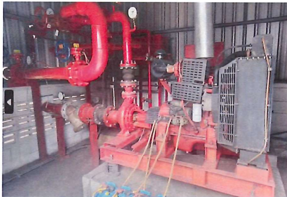
ภาพที่ 61 เครื่องสูบน้ำดับเพลิง
