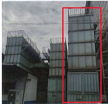
ภาพที่ 12 ปล่องระบบดักฝุ่นจากขั้นตอนการเทแบบ
