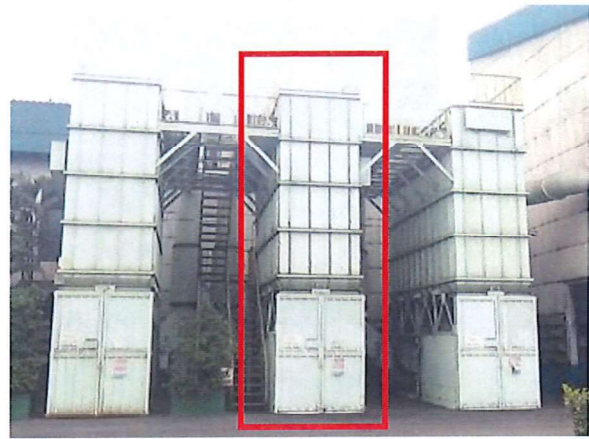
ภาพที่ 8 ปล่องระบบดักฝุ่นจาก Sand preparation No.2 (Line AMF)
