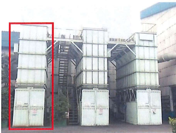
ภาพที่ 7 ปล่องระบบดักฝุ่นจาก Finishing & Grinding No. 2 (Line AMF)
