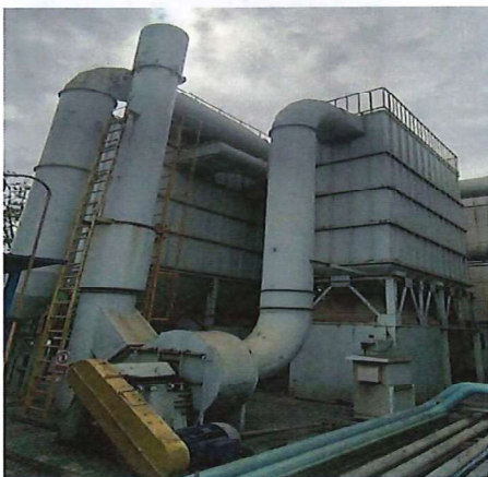
ภาพที่ 11 ปล่องระบบดักฝุ่นจากบริเวณพื้นที่เตาหลอม
