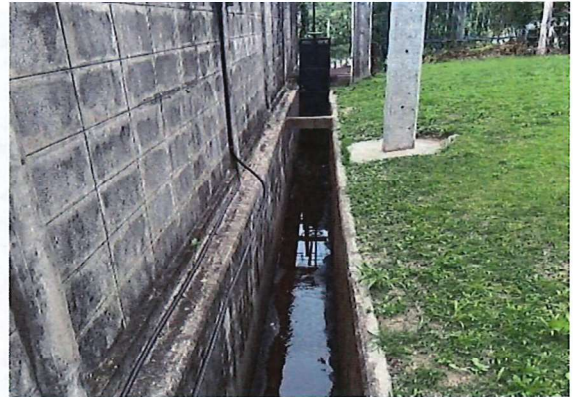
ภาพที่ 24 รางระบายน้ำฝน แยกจากระบบระบายน้ำเสีย
