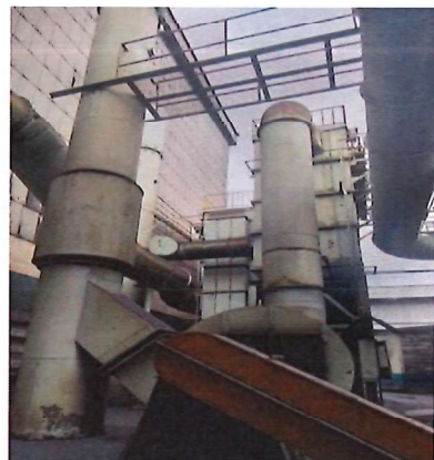
ภาพที่ 4 ปล่องระบบดักฝุ่นจาก Sand preparation (Line ACE)
