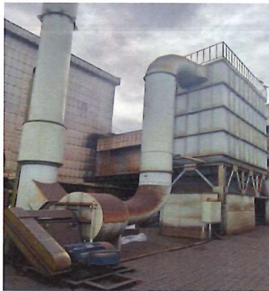
ภาพที่ 3 ปล่องระบบดักฝุ่นจาก Finishing & Grinding (Line ACE)
