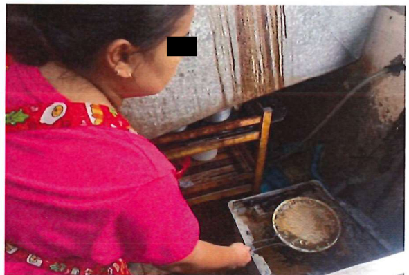
ภาพที่ 28 ทำความสะอาดถังดักไขมัน
